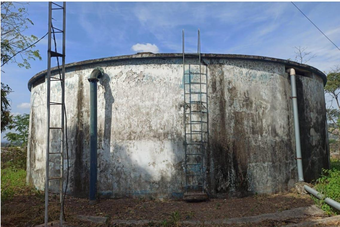
**Imagen 5:** Tanque de hormigón de 1,000m<sup>3</sup>
