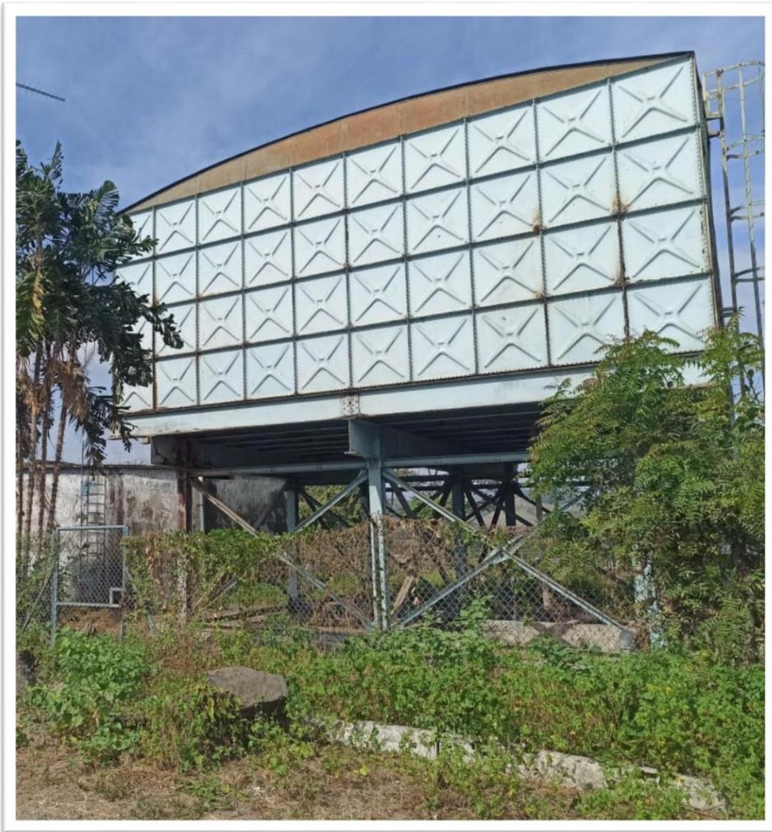
6. Tanque metálico sin funcionamiento, capacidad de 1200m<sup>3</sup>
