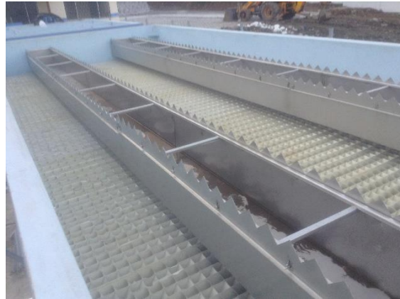
Imagen 20: Sedimentador
