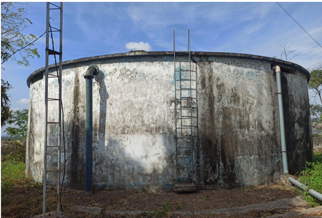
Imágen 5: Tanque de hormigón de 1000 m 3
