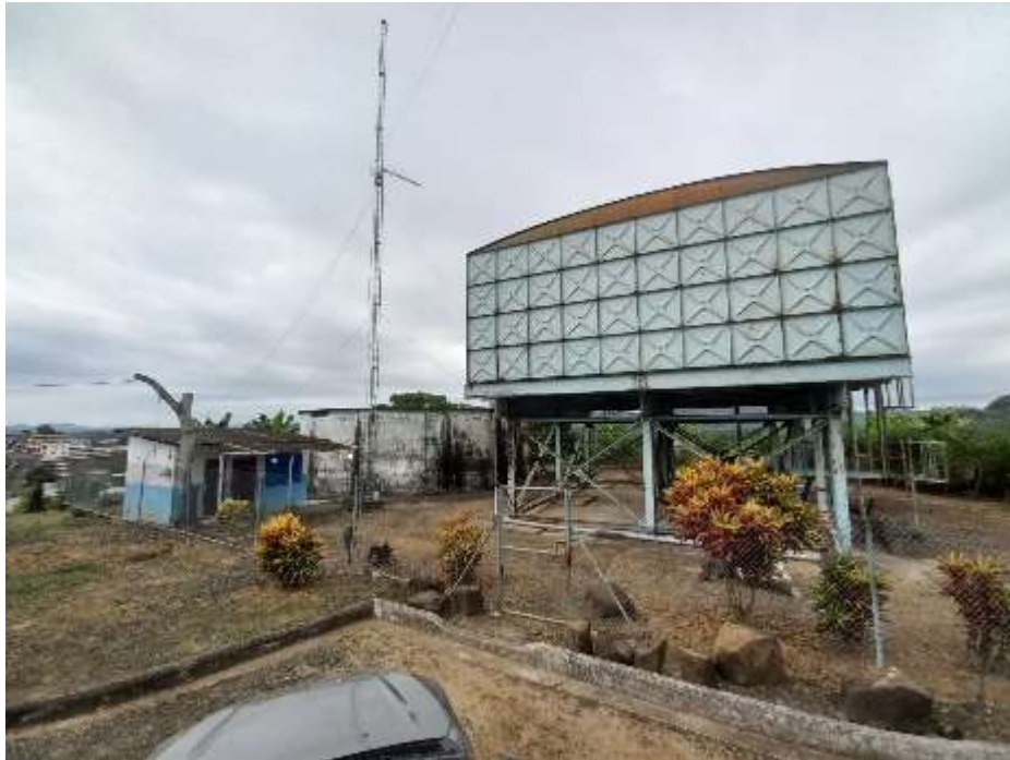
Ilustración 4: Tanques de Reserva de 1.000 m 3 y 800 m 3
